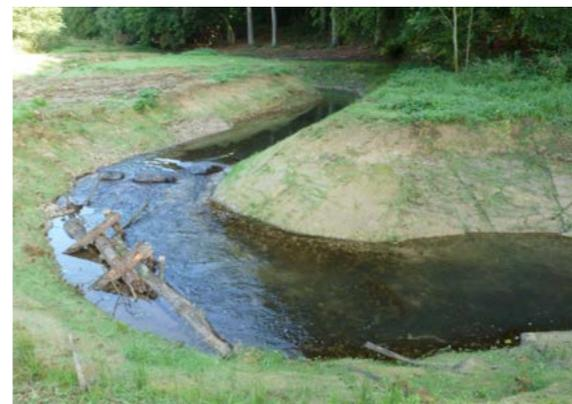
Travaux de reméandration réalisés sur le Bocq dans le cadre du LIFE + WALPHY (DCENN)
