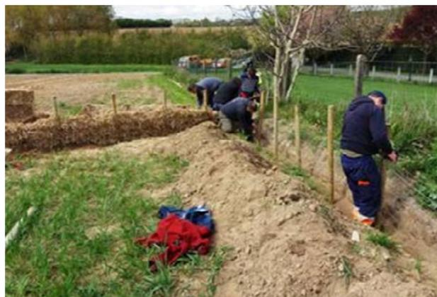
Formation : encadrement des équipes communales pour la pose d'un barrage filtrant (fascine de paille)
