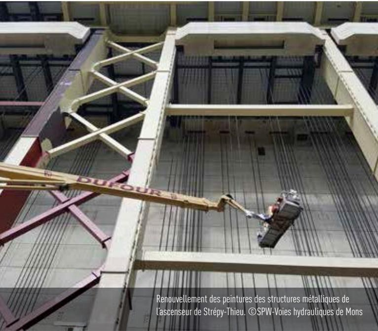
Renouvellement des peintures des structures métalliques de l'ascenseur de Strépy-Thieu. ©SPW-Voies hydrauliques de Mons
