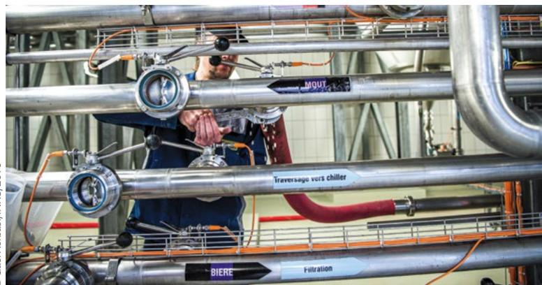
Photo 11.1 – Système de couleur pour le repérage des circuits des différents fluides.
