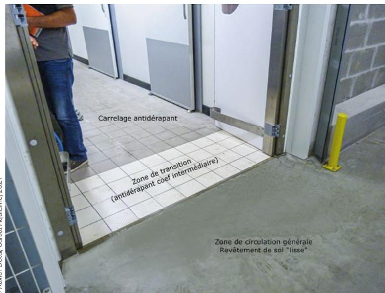
Photo 7.2 – Exemple de revêtement antidérapant avec une zone de transition de coefficient intermédiaire permettant de limiter les risques de chute.
