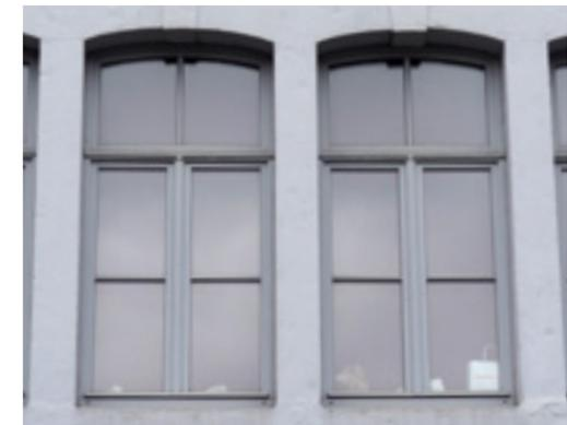
Les châssis en bois sont parfaitement adaptés aux baies d'une façade du 18e siècle, avec une partie supérieure courbe et des croisillons à l'extérieur du vitrage. Les moulures courbes donnent du relief.
