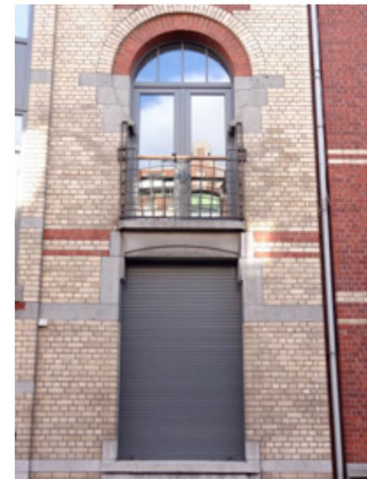
La couleur gris-vert du volet présente le double avantage d'être peu salissante et d'être identique à celle des châssis, pour une harmonie en position close. Le caisson d'enroulement est masqué à l'intérieur.
