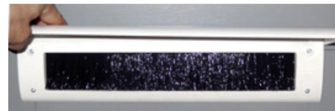
Afin de réduire les pertes thermiques, des brossettes peuvent aussi être placées derrière les ouvertures de boîtes aux lettres intégrées dans les portes. Une autre solution est de placer un petit caisson.
