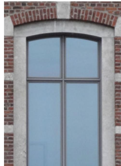
L'aluminium rend possible des profils particulièrement fins. La mouluration donne du relief et de la profondeur à la structure. Relevons ici le cintrage de la partie supérieure.
