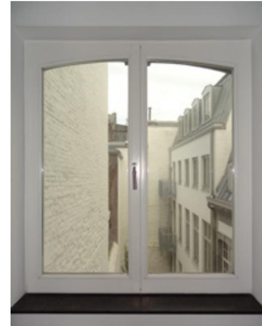
Il est nécessaire de vérifier la qualité des finitions intérieures : présence d'une barrière isolante, qualité du plafonnage, planéité des surfaces, fixation de la tablette...
