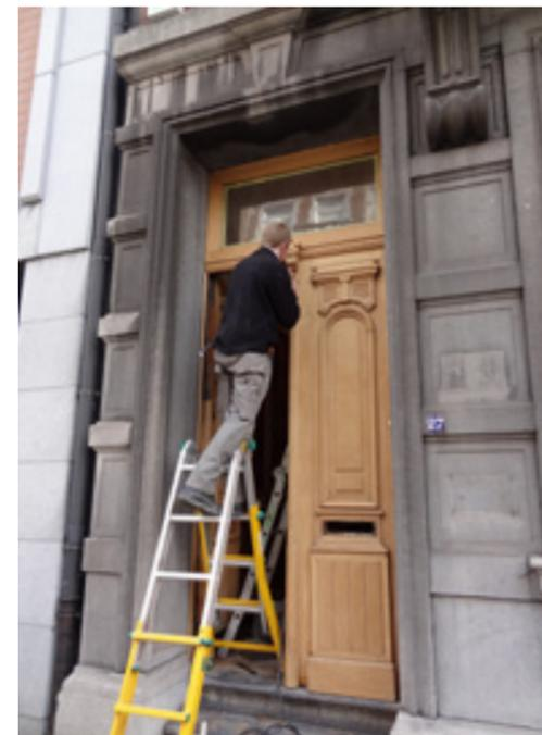
Porte en bois d'origine (fin 19<sup>e</sup>) en cours de réparation : les pièces en bois déformées sont remplacées par le menuisier et l'ensemble est poncé avant la pose d'un nouveau vernis
