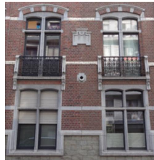
Deux façades jumelles avec des nouveaux châssis : les profils de ceux de droite débordent très peu de l'encadrement en pierre, ce qui assure un éclairage supérieur aux châssis à sections larges de la maison de gauche.
