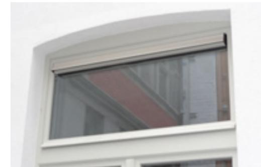
La grille de ventilation est intégrée de manière discrète dans le haut du châssis : l'aération évite les problèmes de condensation.
