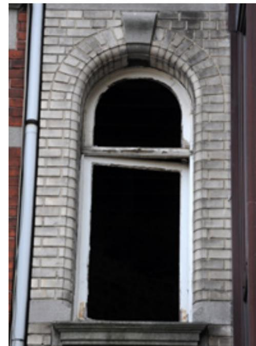
Ce châssis présente des formes simples et adéquates. Vu son état très dégradé, il pourrait être remplacé par un châssis neuf respectant la forme arrondie de l'encadrement.
