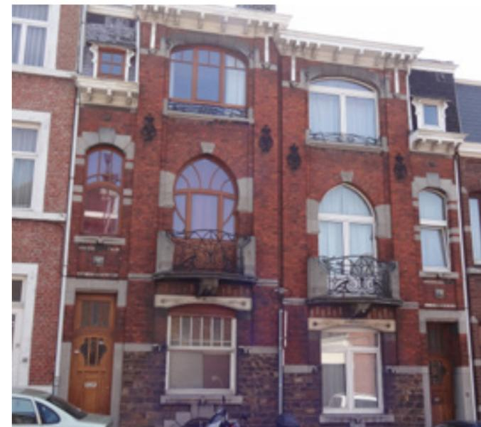
Ces deux façades jumelles de style Art nouveau étaient à l'origine absolument identiques. 😊 Les portes et la grande baie du rez-de-chaussée de la façade de gauche sont les seuls châssis qui sont encore d'origine. Les nouveaux châssis aux étages reproduisent dans le bois les formes courbes originelles. 😞 Les formes rectilignes des châssis de la façade de droite sont simplistes et rompent l'harmonie originale de la façade.
