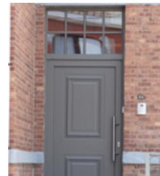
Porte de style traditionnel, avec moulures et fenêtre d'imposte respectant la forme de l'encadrement.
