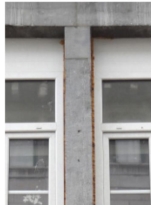
☹ Le dimensionnement des châssis n'est pas adapté à la taille des baies : ils sont trop étroits, ce qui laisse apparent le joint en mousse isolante. Les impostes en partie opaques sont inadaptées à la façade en pierre du 18<sup>e</sup> siècle.
