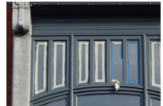
Du papier collant de protection a été placé sur les vitrages pour éviter les taches lors de la mise en peinture.
