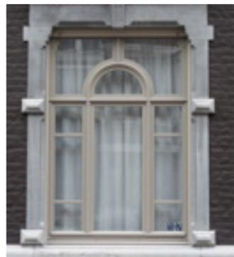
Châssis neuf reproduisant à l'identique les formes et les divisions de l'ancien châssis en bois, avec forme en demi-cercle.
