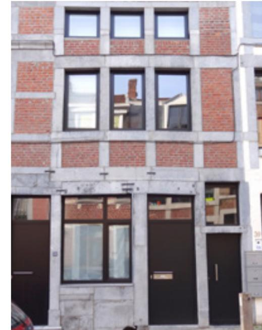
Les châssis de l'étage épousent la forme des encadrements en pierre (17e s.). Le meneau de la fenêtre du rez a été placé dans le prolongement des divisions verticales pour respecter les lignes de force de la façade.
