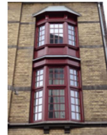
Nouvelle structure reproduisant à l'identique les formes et couleurs de l'oriel d'origine, sur du double vitrage.
