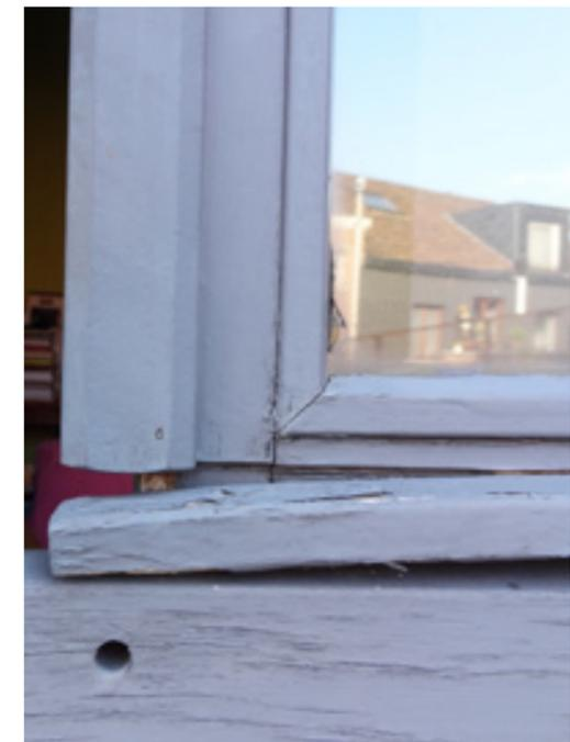
☹ La partie inférieure des ouvrants, appelée le jet d'eau ou rejet, est la partie la plus fragile, car elle reçoit toute l'eau qui ruisselle sur le châssis. Trop abîmée, elle doit être remplacée.
