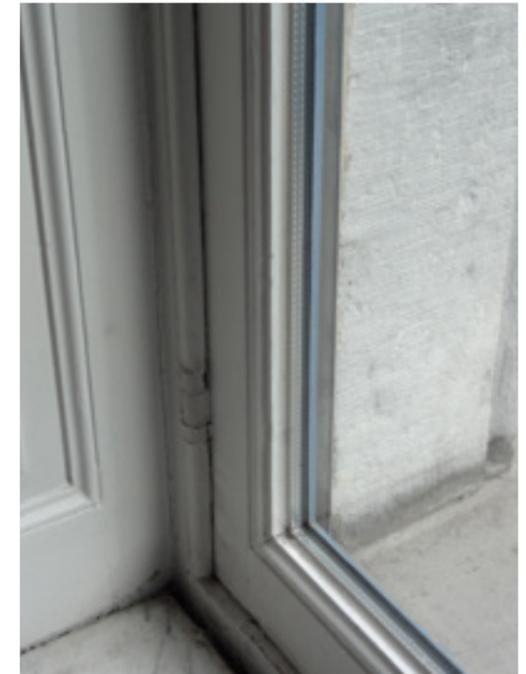
Un double vitrage peut être installé dans la structure d'origine. Certaines firmes sont spécialisées dans ce type de travaux qui permettent de conserver l'aspect historique.
