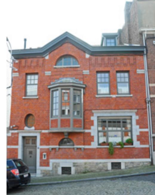
Tous les châssis de cette façade ont été remplacés en même temps, dans le même matériau et la même teinte. Les formes choisies pour la porte et les fenêtres forment un ensemble cohérent, adapté au style de la façade.
