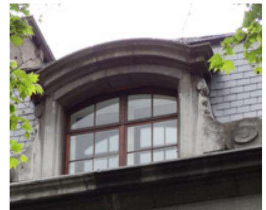
La pose d'un second châssis vers l'intérieur a permis d'améliorer les performances thermiques de la baie tout en conservant les structures d'origine.
