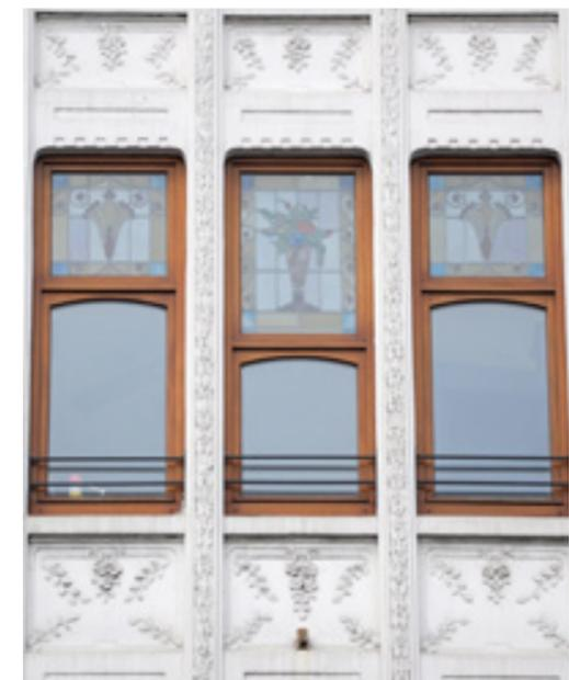
Vitraux des années '30 remontés dans une structure de châssis neuf. Ils sont fixés du côté intérieur, derrière un vitrage de protection qui atténue leur visibilité depuis l'espace public.
