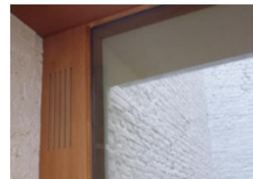
Exemple de système de ventilation 'invisible', intégré dans le montant du châssis en bois.
