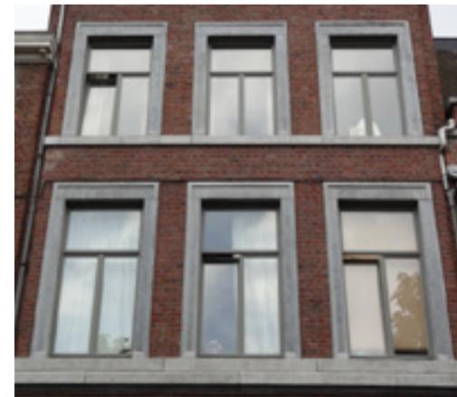
Nouvelles fenêtres avec division en T classique : l'imposte (partie fixe) est transparente, positionnée dans la partie supérieure, aux 2/3 de la hauteur de la baie.
