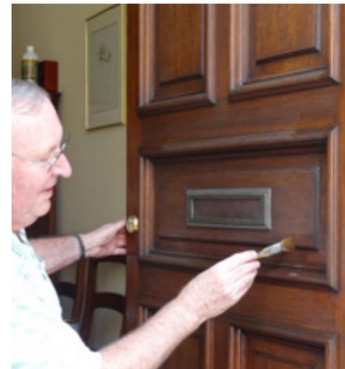
Un entretien régulier des châssis permet de les conserver longtemps (dans cet exemple, une nouvelle couche de vernis est appliquée sur une porte en bois).
