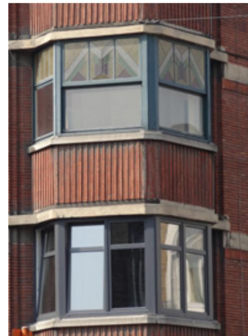
☹ Le remplacement de certains châssis (en bas) entraîne une perte d'authenticité de l'ensemble du bâtiment. Des solutions existent pourtant pour réintégrer les vitraux dans de nouvelles structures.
