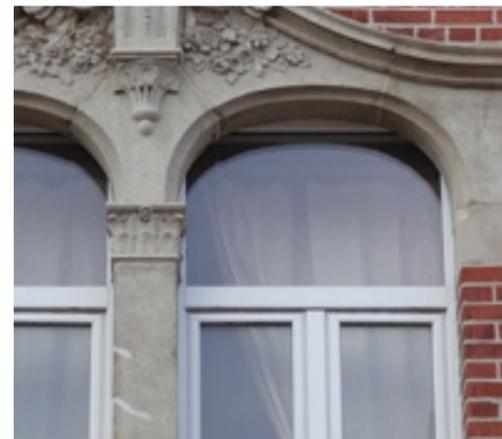
La forme droite du nouveau châssis n'est pas adéquate : le vitrage est en partie masqué par la courbe de l'encadrement en briques.
