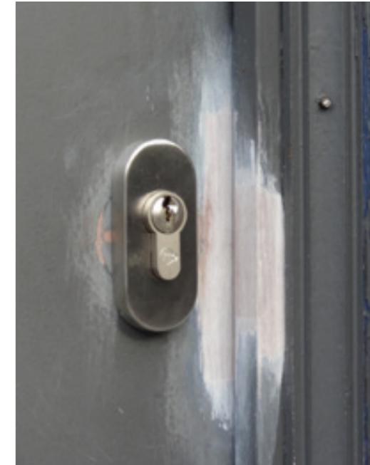
Alors que les châssis en PVC ou en alu doivent être entièrement remplacés en cas de sinistre, les portes en bois peuvent facilement être réparées : les parties remplacées sont enduites avant remise en peinture.
