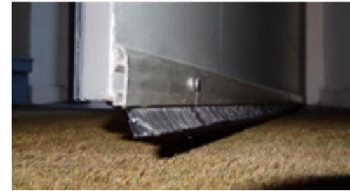
L'ajout d'une brossette isolante contre la partie inférieure du battant constitue une autre solution pour améliorer l'étanchéité en contact avec le seuil.
