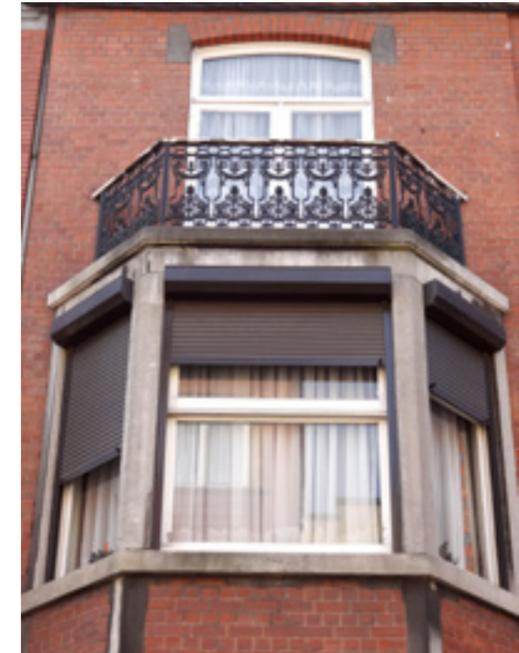
☹ Les caissons d'enroulement en PVC placés à l'extérieur alourdissent et banalisent la façade.
