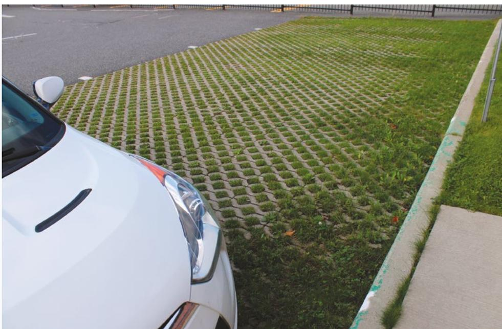
Un parking en pavés alvéolés permet une meilleure infiltration des eaux pluviales tout en limitant l'artificialisation du sol. Il nécessite que quelques conditions soient réunies pour remplir sa fonction au mieux : ensoleillement, apport en eau suffisant, passage modéré.
